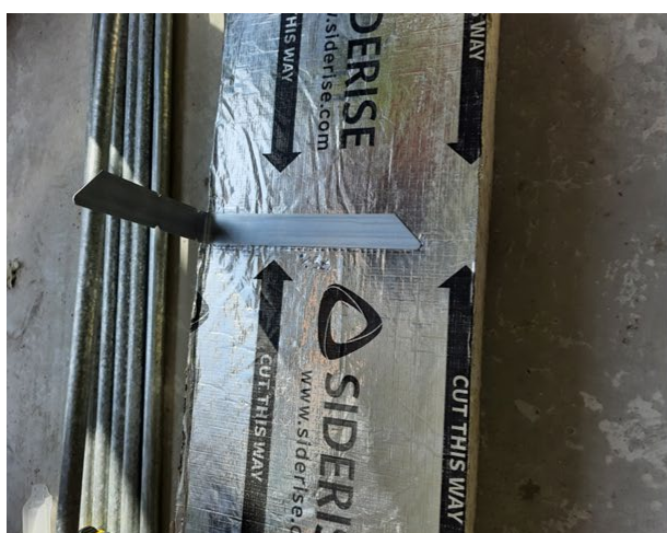
Figur 1 Montering af CW-FS BrandStop
