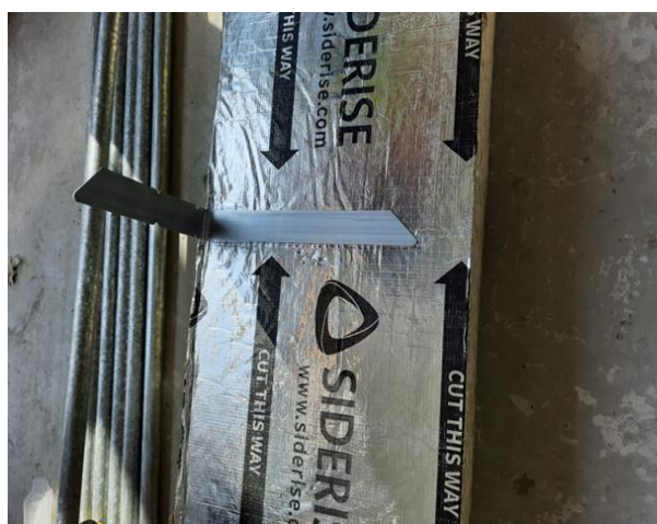
Figur 8 Montering af CW-FS BrandStop
